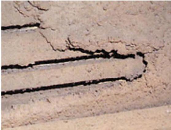
Intonaci applicati a spruzzo per il rivestimento di superfici (*ad es. di soffitti oppure di strutture metalliche, travature*) allo scopo di aumentare la resistenza al fuoco
