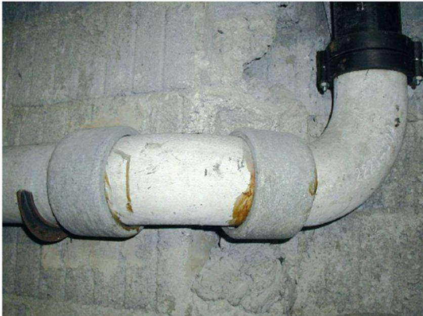
*Condutture in cemento-amianto*
