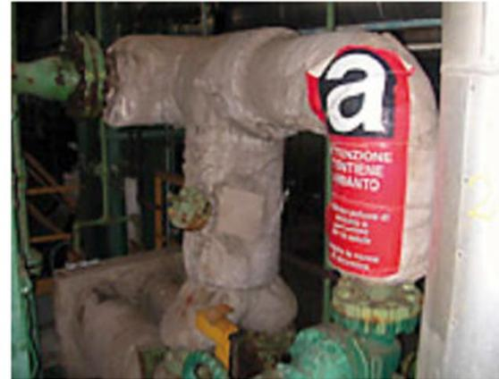
Rivestimenti di tubazioni per il trasporto di fluidi ad alta temperatura costituiti da avvolgimenti di nastri in tessuto contenente amianto, oppure impasti di tipo gessoso
