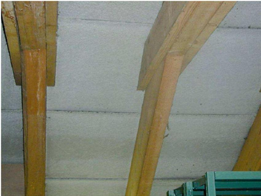
*Isolamento del tetto con lastre in cemento-*
