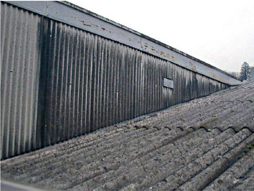
*Lastre di copertura in cemento-amianto*
